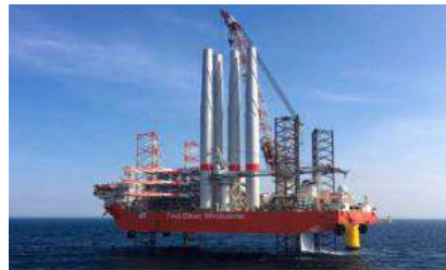
b) Embarcação de instalação de turbinas eólicas
